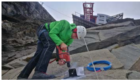
Einbohrung Extensometer
